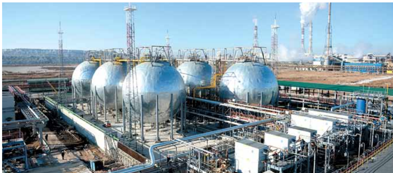
↶ Монтаж шаровых резервуаров 3000 м 3 ↷
