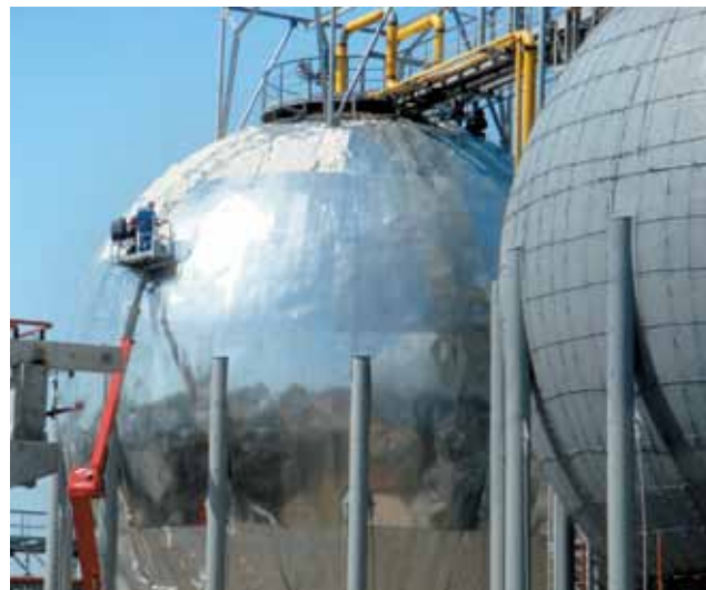
↶ Монтаж шаровых резервуаров 3000 м 3 ↷
