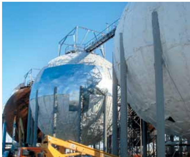
↶ Монтаж шаровых резервуаров 3000 м 3 ↷
