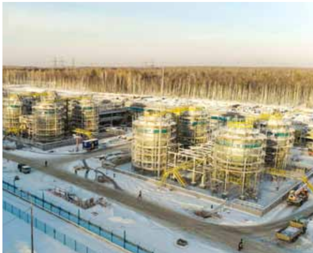
Парк хранения ШФЛУ. Шаровые резервуары 600 м 3
