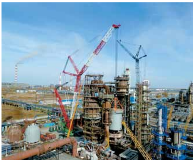
⤴ Монтаж оборудования реакторно-регенераторного блока секции каталитического крекинга на Омском НПЗ
