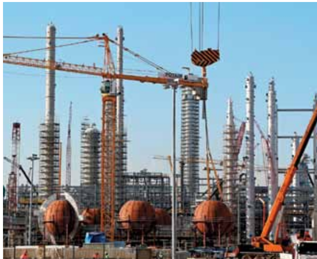
Промежуточный парк хранения бутадиена. Шаровые резервуары 600 м 3
