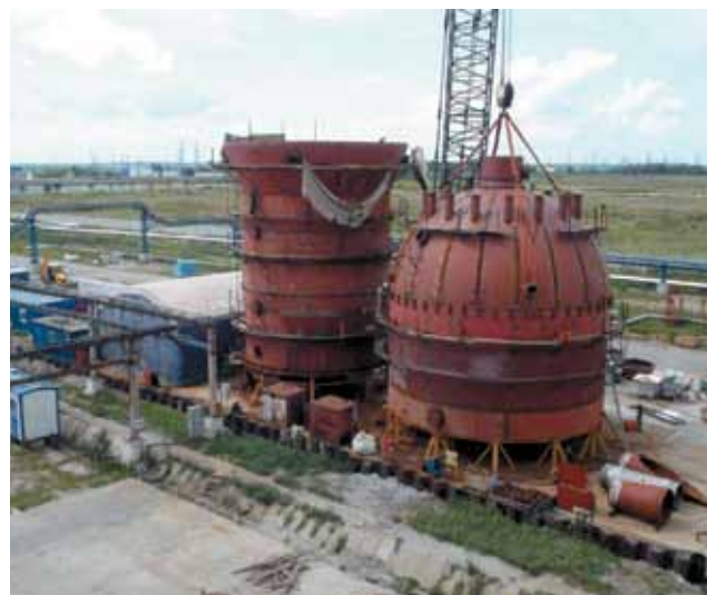
⤴ Монтаж оборудования реакторно-регенераторного блока секции каталитического крекинга на Омском НПЗ
