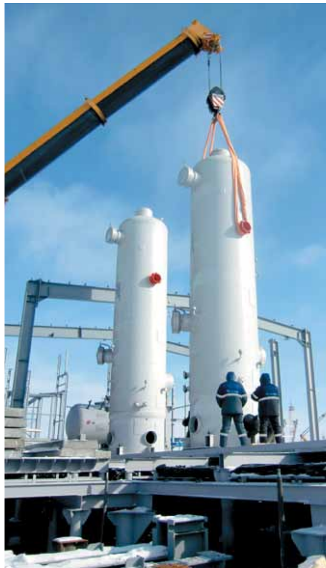
⤴️ Установка сепараторов 10С-1 в проектное положение
